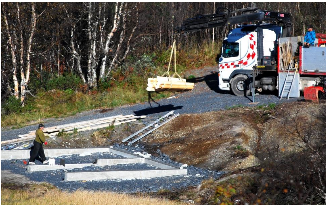
Oppsetting av båthus ved Sæbu-Røssjøen
