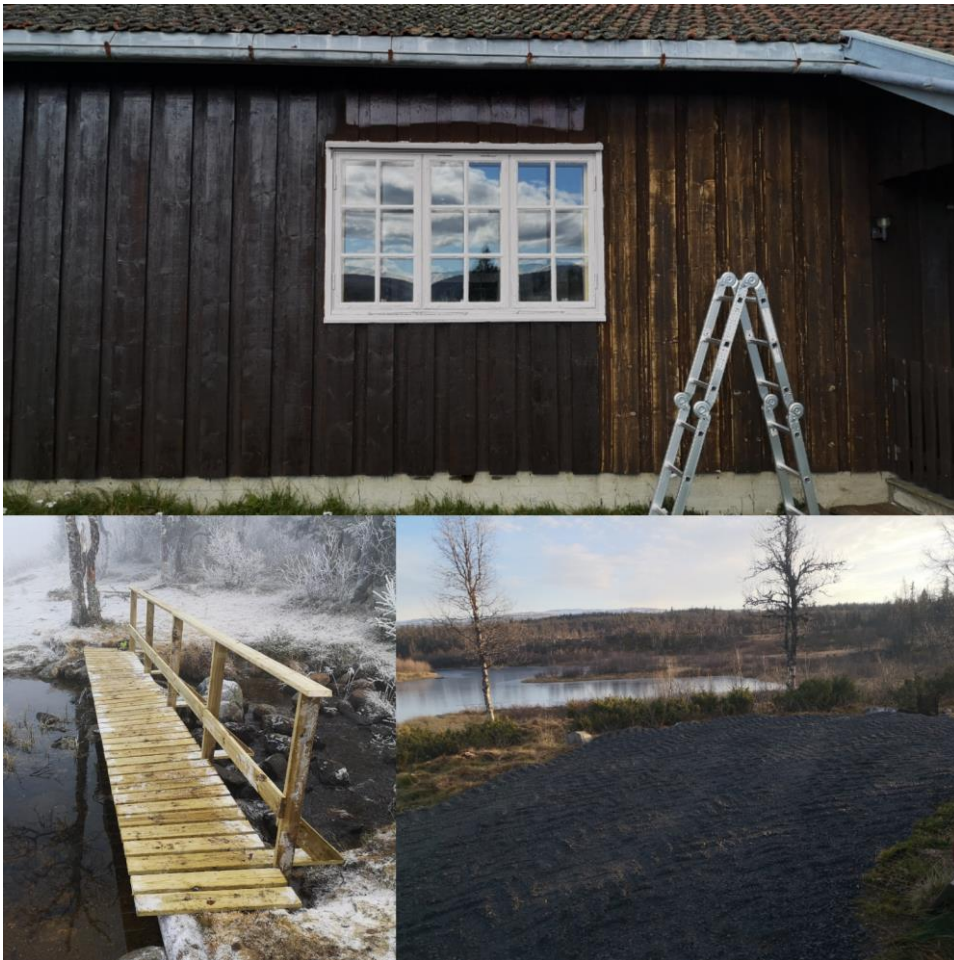
Beis av vegg Leikvamlægerhytta, gangbru over Oppsjøputten og uteområdet Folungtjernhytta
